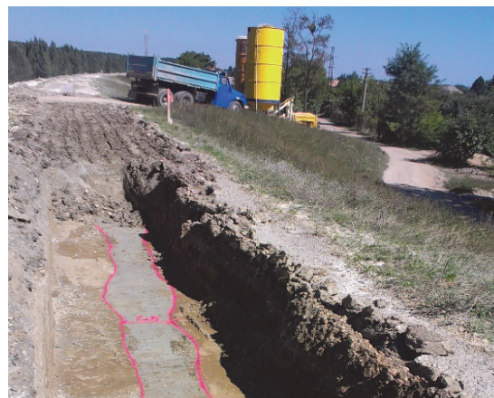
Obr. 6. Odkop pre kontrolu hrúbky PTS (foto: z archívu SVP, š.p., 2013).
