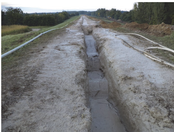
Obr. 5. Realizácia podzemnej tesniacej steny (foto: z archívu SVP, š.p., 2013).
