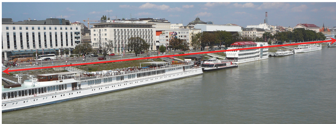
Obr. 1. Úsek realizácie protipovodňovej ochrany v Bratislave.
