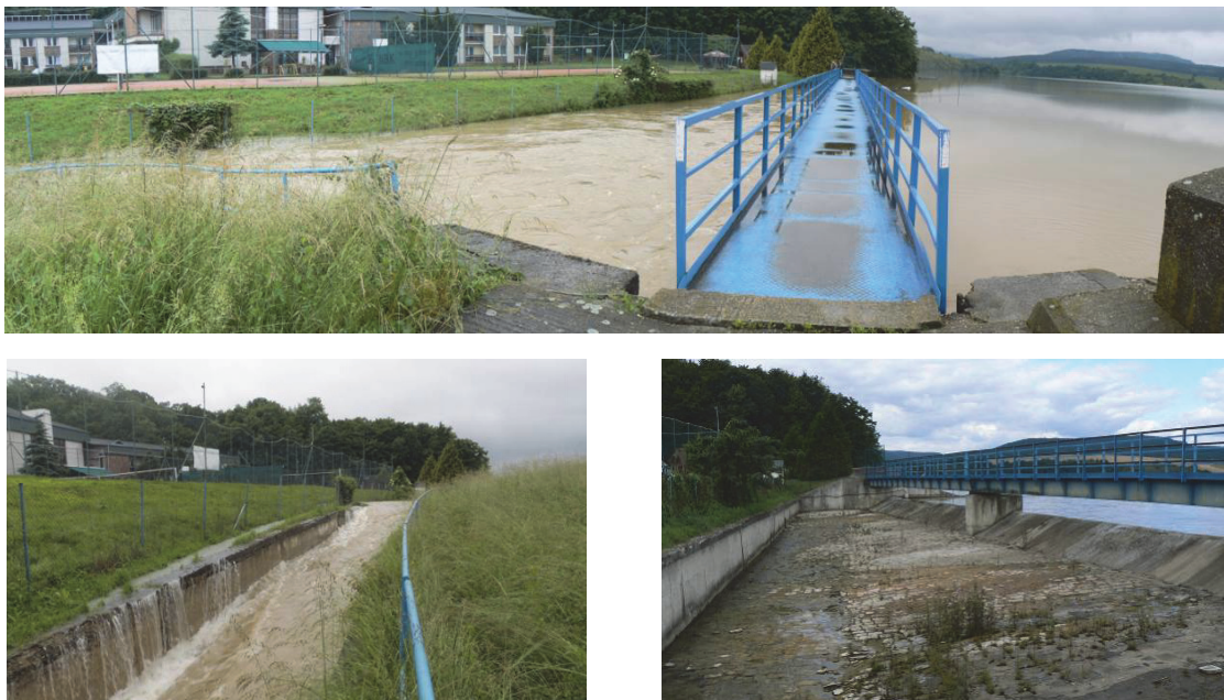
Obr. 2. Bezpečnostný prípad priehrady Teplý Vrch, ktorý mal podľa pôvodného projektu previesť povodňové prietoky do 60 \text{ m}^3 \cdot \text{s}^{-1} , no v roku 2010 tadiaľ tieklo cca 16 \text{ m}^3 \cdot \text{s}^{-1} a voda z priepadu a sklzu vybrežovala.
