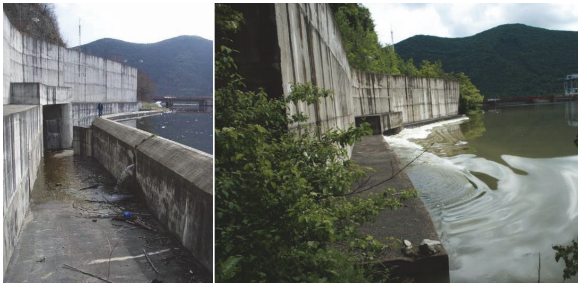
Obr. 1. Bočný bezpečnostný priestor s tunelovým obtokom na priehrade Ružín I počas povodňových prietokov v roku 2010 – počas prekročenia max. retenčnej hladiny (v strede ľavej fotky je ako mierka postava človeka stojaceho na hrane priestoru).
